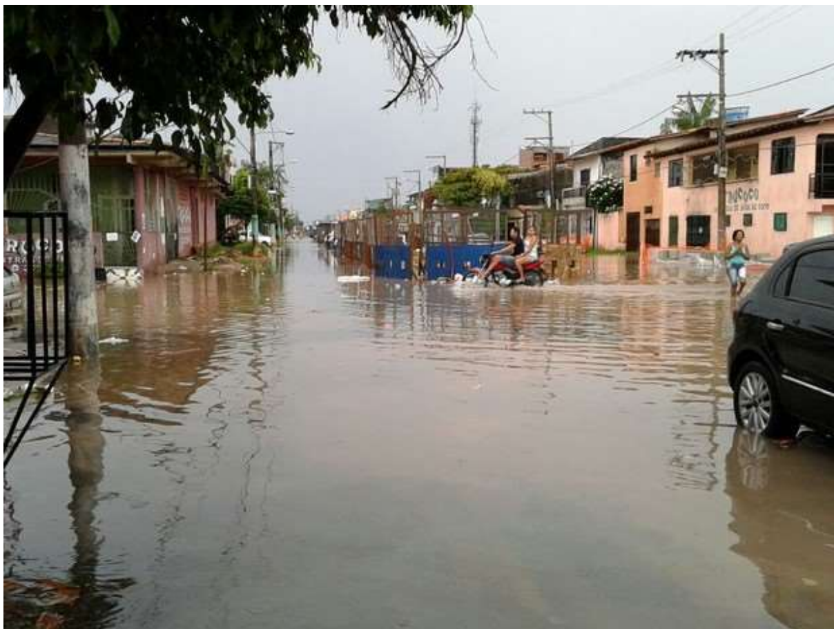
Figura 06- Rua dos Timbiras teve diversos pontos de alagamento
