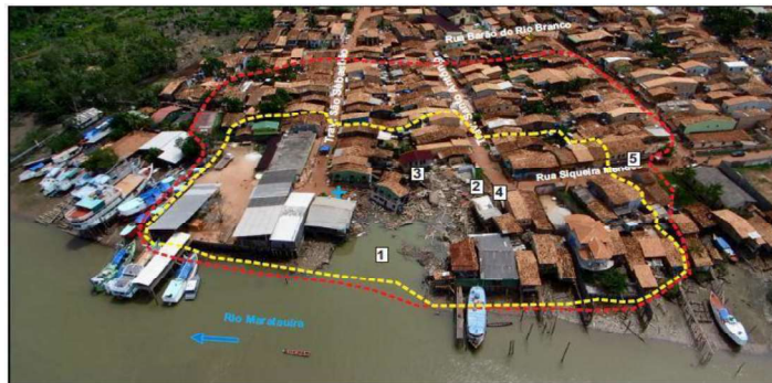
Figura 2: Rua Siqueira Mendes com a delimitação de espaços sujeitos ao risco à colapso de aterro (linha pontilhada amarela) e área de interdição (linha pontilhada vermelha).
