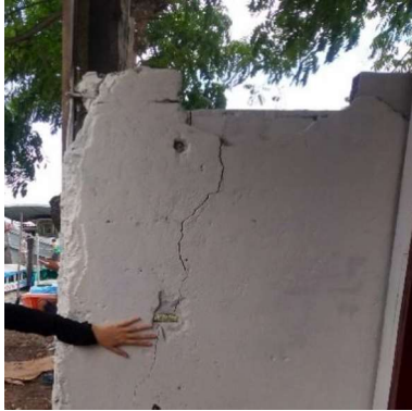
Figura 18 - Ponto “P8”. (A) Trincas de aproximadamente 0,04 cm. (B) Trincas de aproximadamente 0,08 cm. (C) Barreira de Retenção.
