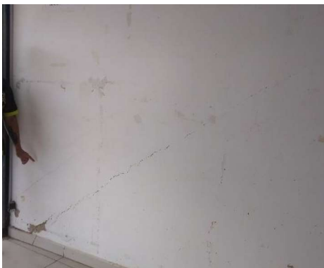
Figura 14 - Ponto “P5”. (A) e (B) Trincas.
