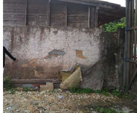
Figura 18 - Ponto “P8”. (A) Trincas de aproximadamente 0,04 cm. (B) Trincas de aproximadamente 0,08 cm. (C) Barreira de Retenção.
