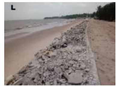
Imagem L - Erosão de parte do muro de contenção – Segmento Marahú (2019)
