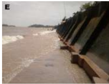
Imagens D, E e F - Muro de contenção para conter a erosão – Segmento Paraíso (2019)
