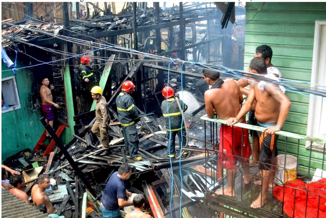
Figura 10- Incêndio no bairro do Jurunas em Belém (PA)
