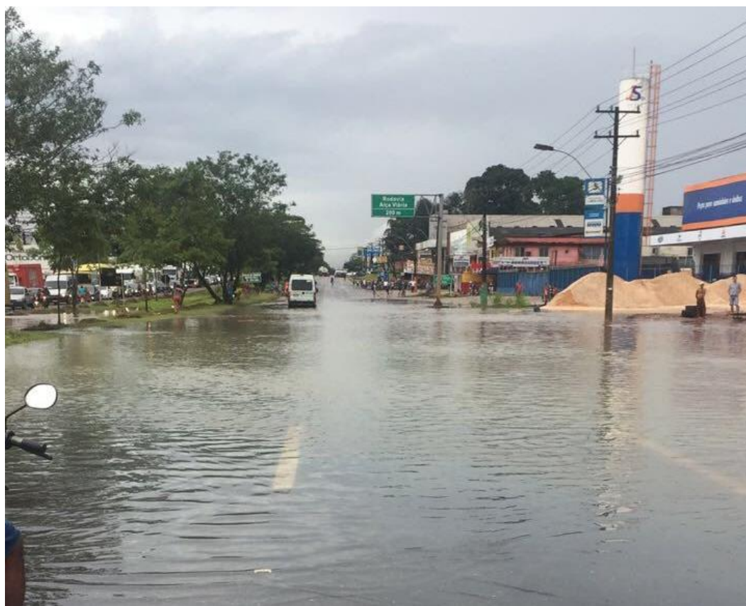
Figura 05- Registro da BR 316 alagada no mês de março de 2020.
