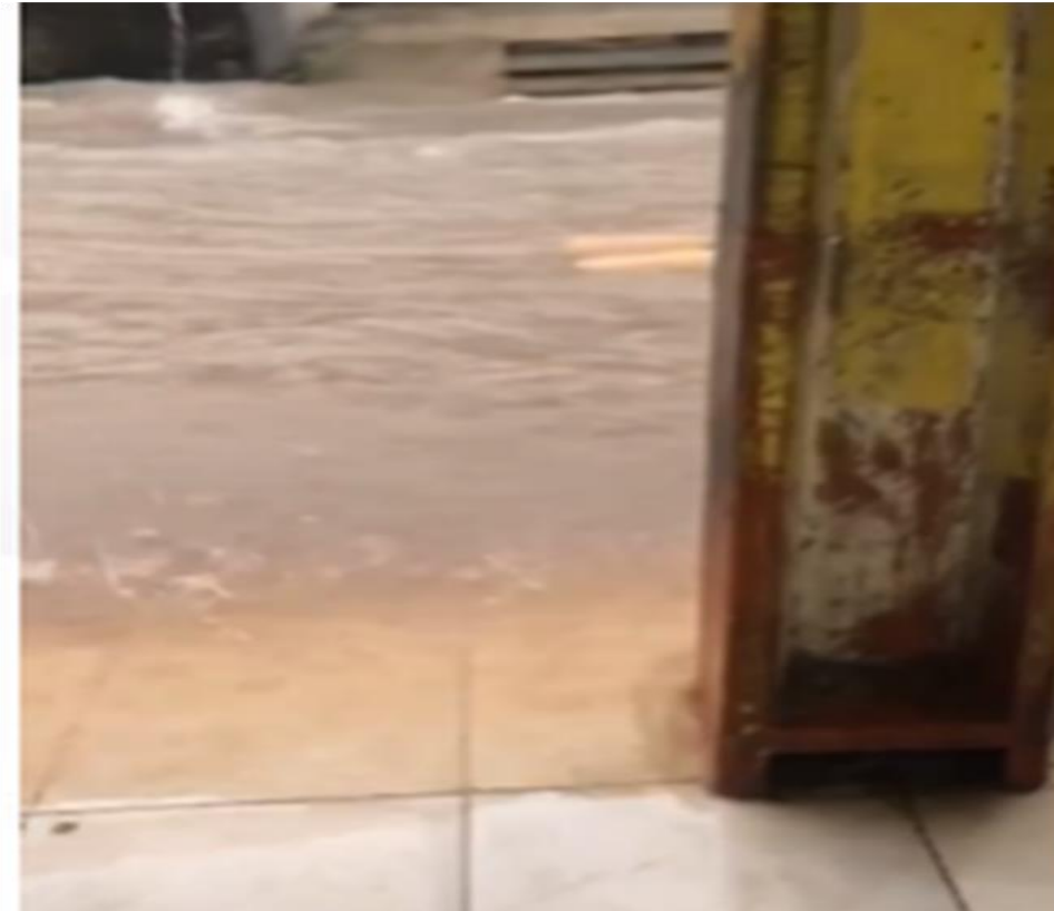
Figura 03- Registro da BR 316 alagada no mês de março de 2020.
